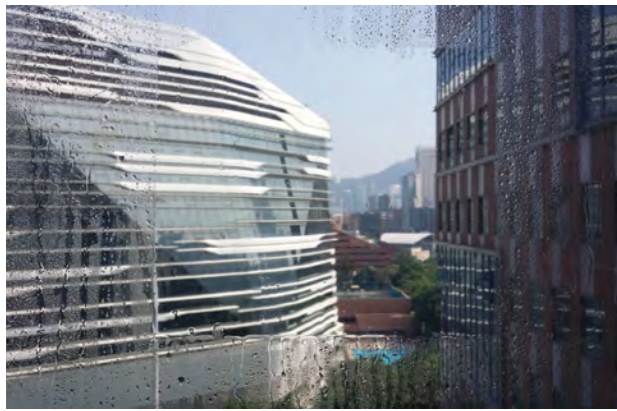
▲ 理大校內已採用一幅塗上自潔塗層的玻璃幕牆。
