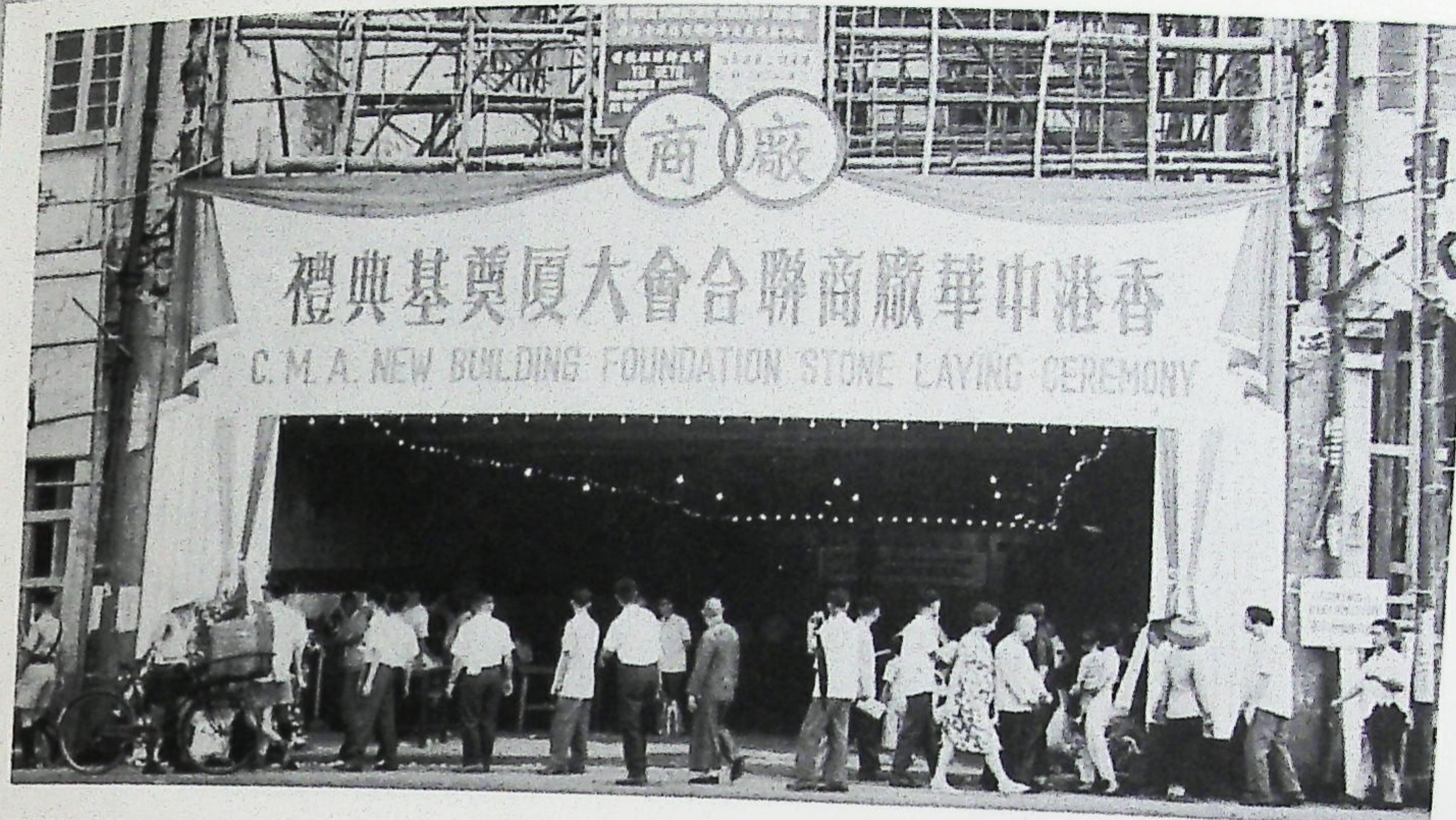
大廈奠基時之基地牌樓
