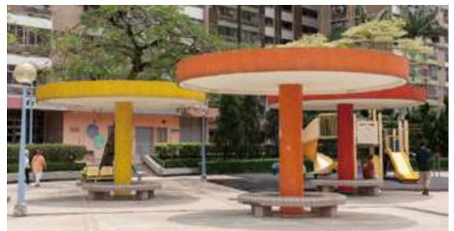
從涼亭的設計可看出設計師的巧思：柱子收藏去水管，而且傘部安裝的街燈，不會影響涼亭外觀
