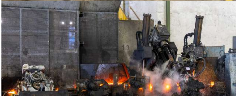
紹榮鋼鐵要打入大灣區內地市場，鋼材強度必須符合區內標準，新技術能製造出可滿足區內建造業市場需要的新鋼材。
